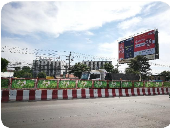
การลดผลกระทบด้านทัศนียภาพตามแนวพื้นที่ก่อสร้าง โดยการติดตั้งผ้าใบพิมพ์ลายต้นไม้ และดอกไม้
